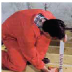
5 Pose des piges pour la mesure de l'épaisseur d'isolant lors du soufflage.
