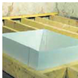
2 Entourage de la trappe d'accès
